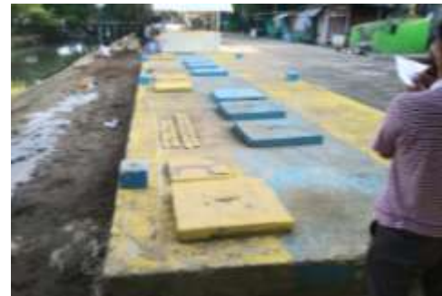
Fig. 2. Old WWTP Sekanak
