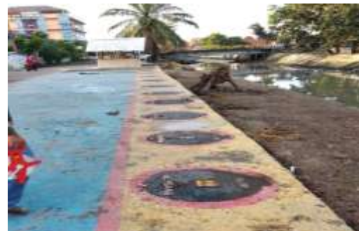
Fig. 3. New WWTP Sekanak
